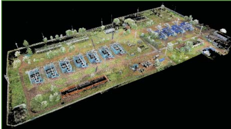
Рис. 1 Результаты наземного лазерного сканирования компрессорной станции «Алексеевская» в виде единого облака точек
