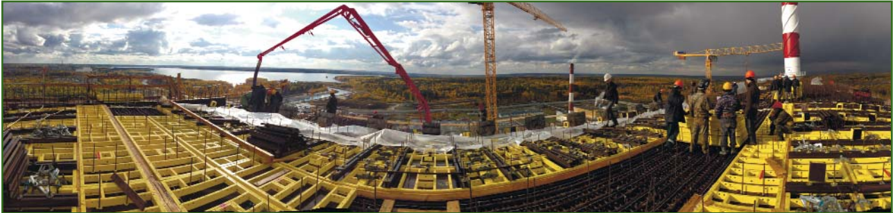
Рис. 5 Панорама свода снаружи (процесс бетонирования)
